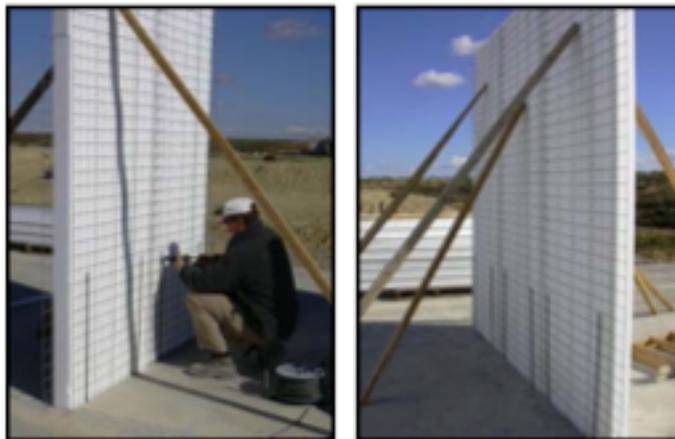
*Los paneles paneling de muros se colocan de manera vertical introduciendo el panel dentro de los anclajes previamente colocados, quedando las varillas del anclaje, entre la malla electrosoldada y la placa de foam. Para realizar esta operación se necesitan dos (2) o más instaladores dependiendo del tamaño del muro.*
