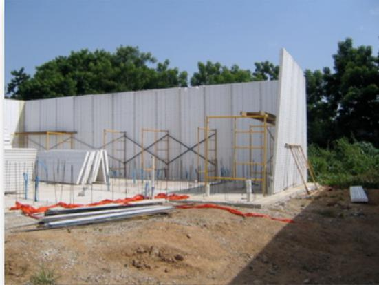
IV.4. Con el ESQUEMA DE MARCOS, ubique las jambas, dinteles y antepechos correspondientes a cada abertura e inicie el montaje de los marcos de ventanas y puertas a medida que avanza con los muros.
