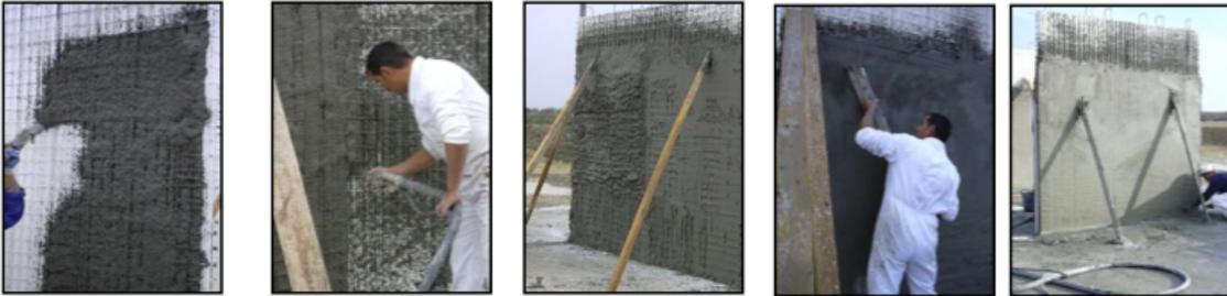
NOTAS: Los antepechos de ventanas deben llenarse antes de continuar con el resto de los muros. Todos los muros, deben ser revocados en forma pareja y en su totalidad. Para realizar las mochetas luego de haber realizado el revoque, se deprime el foam en toda la orilla del marco de las puertas y/o de las ventanas y se completa la parte extraída con mortero estructural.
