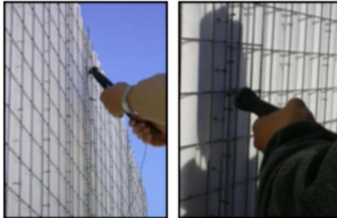
Recomendamos que se empleen equipos de tres o cuatro personas para el montaje de los muros, dependiendo del tamaño de la edificación la cantidad de equipos a utilizar. Una de ellas se dedicará a la instalación de los muros, una o dos irán alcanzando las piezas, y la otra realizará la lectura del ESQUEMA DE MUROS, seleccionando los componentes que se requieran (esta persona debe ser la mas capacitada del equipo).
