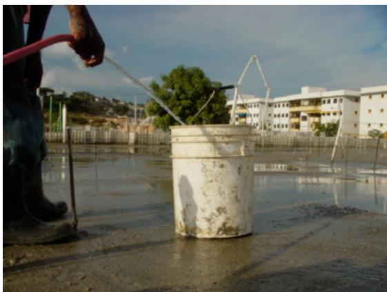
Recomendamos dejar fraguar el hormigón por lo menos 72 horas antes de instalar los anclajes (según el tipo de fijación usada), si se utilizan aditivos acelerantes de fraguado, el tiempo podría reducirse según el caso.
